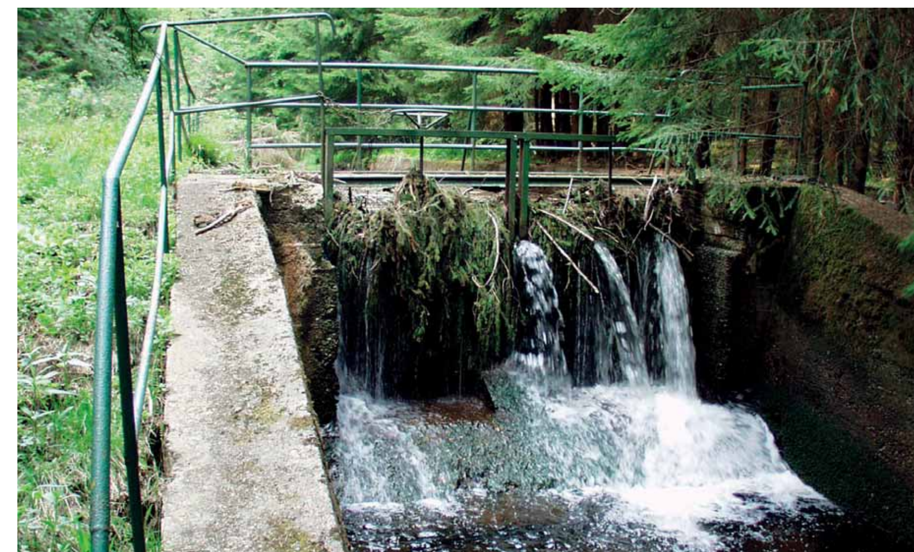
Jímání vody Bystřiny pro úpravnu vody v Rotavě / Fassung des Zwieselbaches für die Wasseraufbereitung in Rotava
